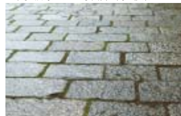
湘南キャンパスの富士見通り、榊並木、武道館門歩道などで見られる敷石。かつて都電の敷石として使われていたもの
